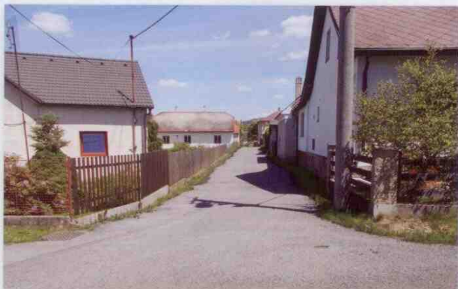
Spojovací ulička na „Kudibalce“ před opravou a po opravě.
