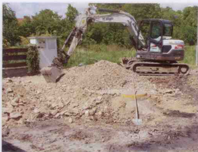
Obnova povrchu místních komunikací v části „Poříčiny“.
